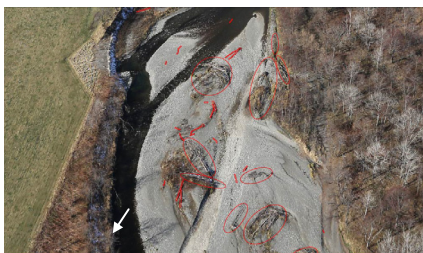
写真-1 紋別川①における砂州発達と流木堆積状況
