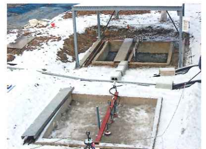
写真4 浚渫ヘドロの凍結脱水実験
