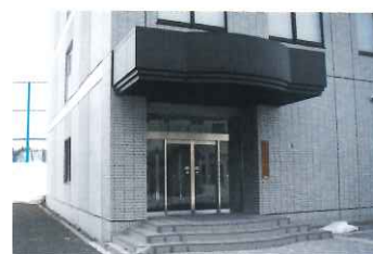
機器分析センターの外観
