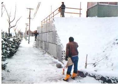
写真1 多数アンカー擁壁の凍上実験
