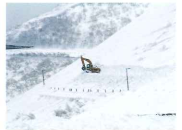
知床横断道路の除雪作業
