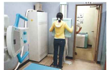
写真3 「レントゲン撮影装置の更新」 写真の右、操作室内の装置がFCR本体である。また、中央部から左側にかけての機材が、更新したレントゲン「インバータ方式X線高電圧装置」（一般撮影装置）一式である。
