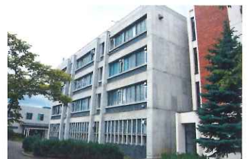
2号棟改修前の学科棟
