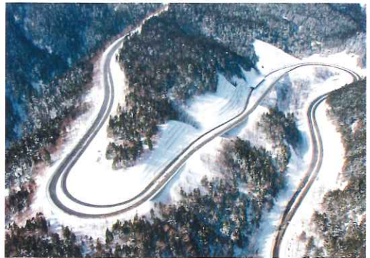
国道39号石北峠付近の山間部道路
