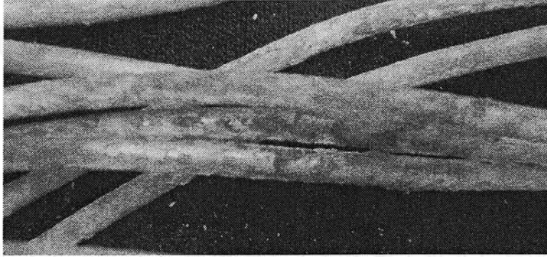
図5 経年変化した送電線の解体(中間層アルミニウム線)
