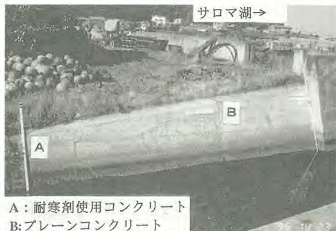
写真4 寒中コンクリートの施工
