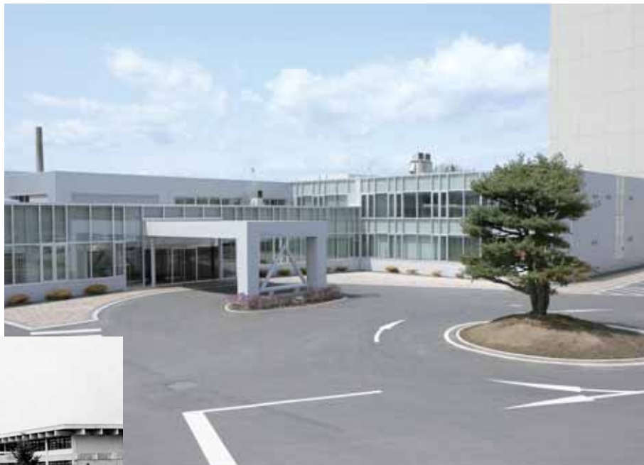
平成19年5月に改修された一号館
