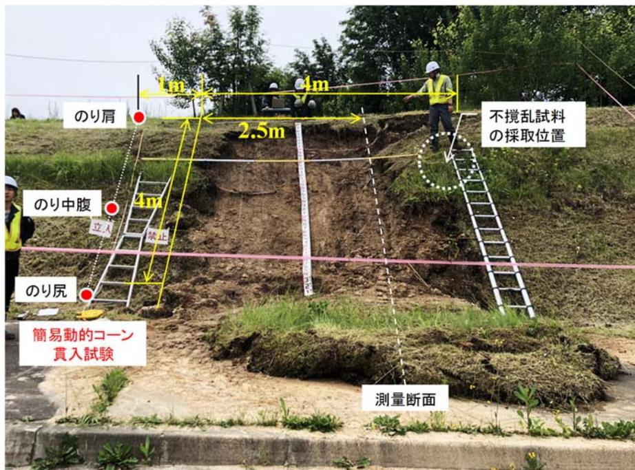
図2-2 斜面崩壊が発生した道路のり面の全景
