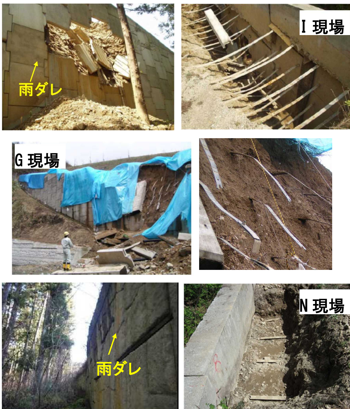
写真 1-3 テールアルメの壁パネル脱落、はらみ出し、ストリップ損傷状況
