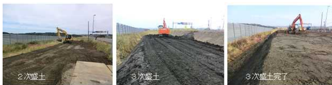
写真 3-2 拡幅 2 次盛土および 3 次盛土施工状況
