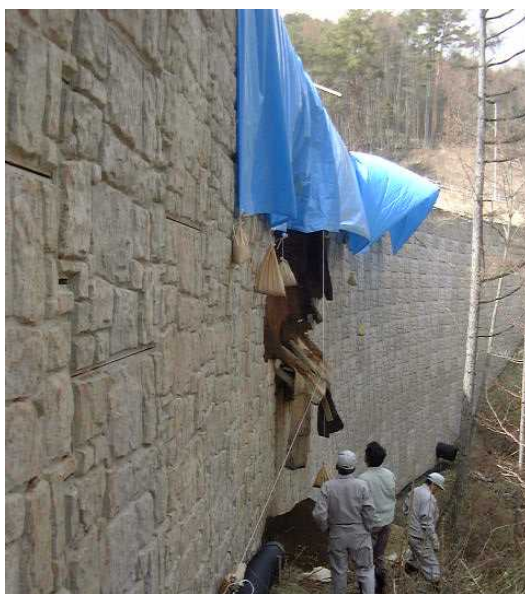
写真1-1 岡谷市でのテールアルメ変状事例
