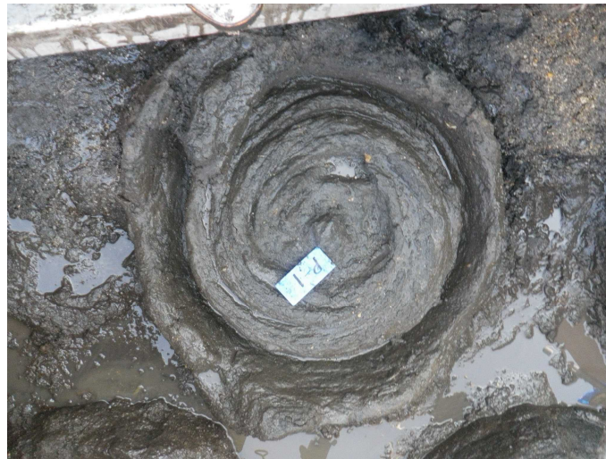
写真 2-7 改良体頭部の露出
