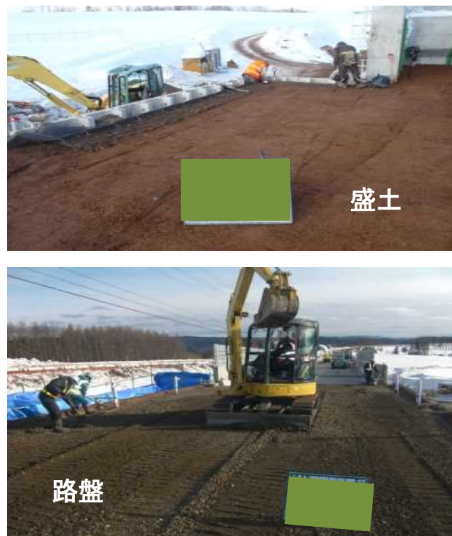
写真 5-1 盛土, 路盤の施工状況
