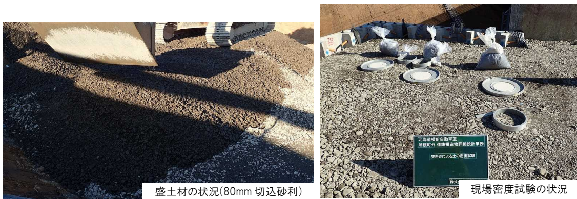
図 5-15 再構築時の盛土材による施工および現場密度試験
