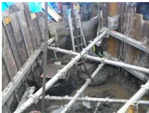
写真 2-4 切梁の設置完了
