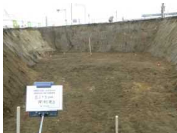
写真 2-2 EL=5.0m 開削状況(小段部)
