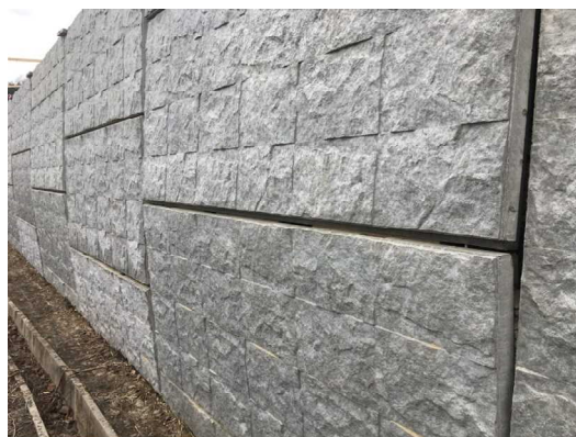
写真 5-4 壁面パネルの変状状況(ボーリング調査 A 点付近)
