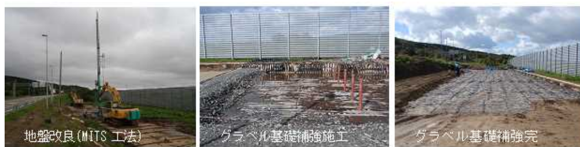
写真 3-1 地盤改良(MITS 工法)およびグラベル基礎補強の施工
