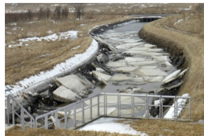
写真-1 新釧路川左岸河口から4.5 km地点で確認された津波由来の漂流氷板 (2011年3月14日撮影)
