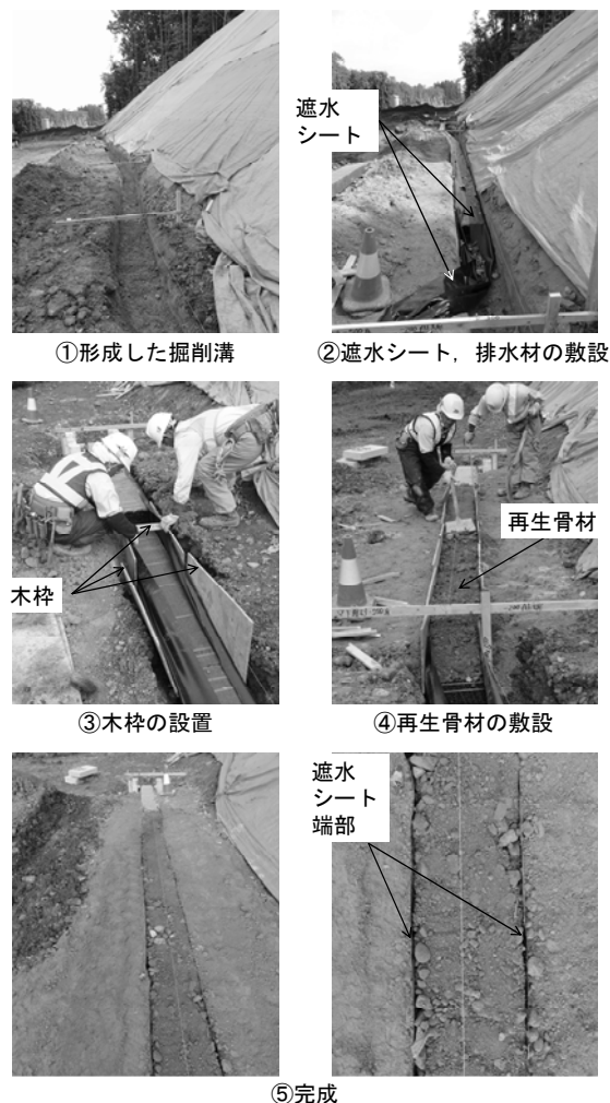
図-2 開発した小段排水溝の施工手順
