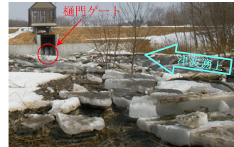
写真-1 北海道の河川における津波遡上痕跡(2011.3.14撮影)
