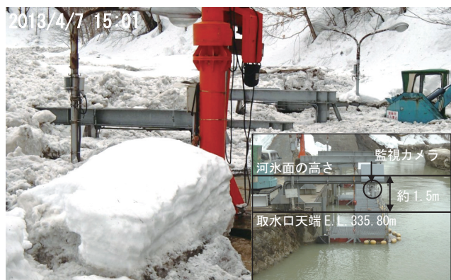
写真-1 取水口の状況 2013/4/7 ダム管理支所撮影
