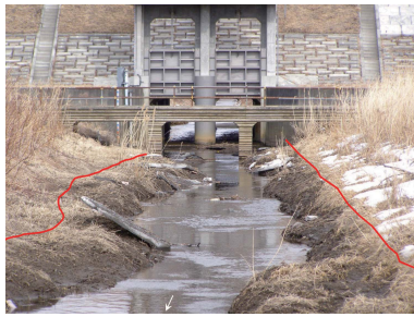
写真-2 対象樋門の概況 (2011/3/14 撮影)
