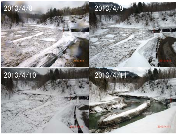
写真-3 河氷の集中流下と滞留、閉塞、解氷までの取水口の様子
