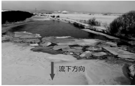
写真-2 実河川橋脚部で滞留する多数の氷板 (2009年2月撮影)
