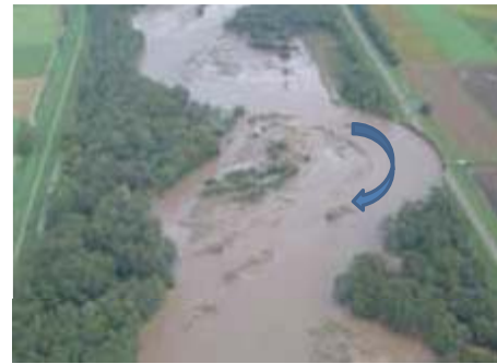
図-2 河岸浸食による堤防流出
