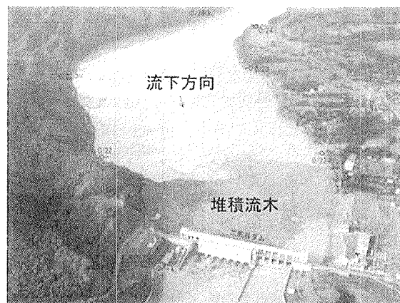
図-1 二風谷ダム流木災害状況 (2003 年 8 月撮影)
