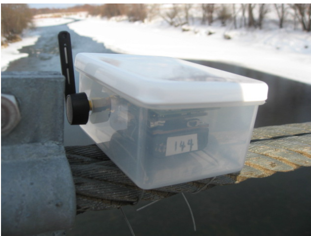
写真-3 センサー設置状況
