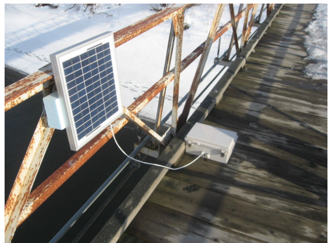
写真-4 耐低温測定システム設置状況
