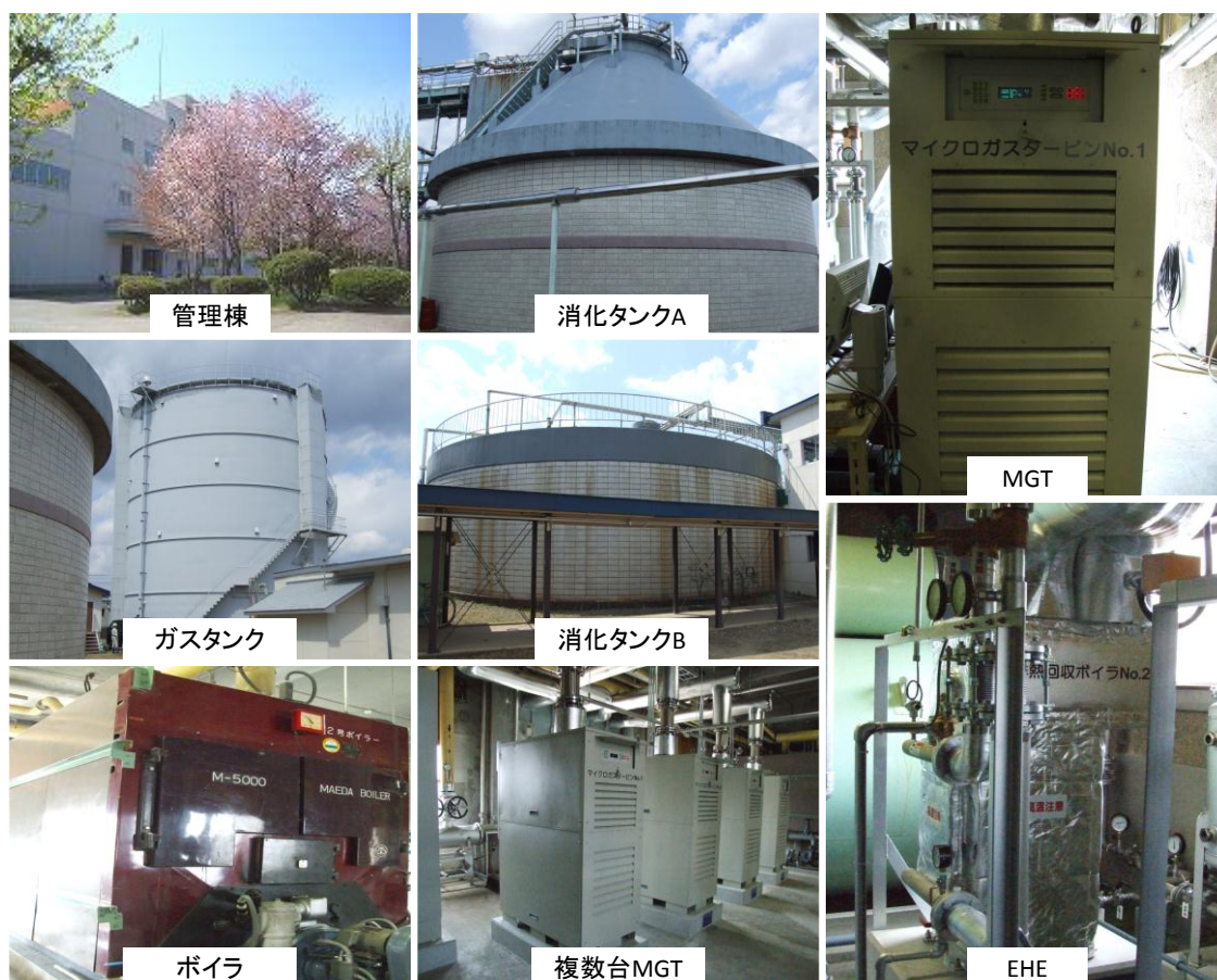
図 2.4 下水処理施設内の各部分の写真
