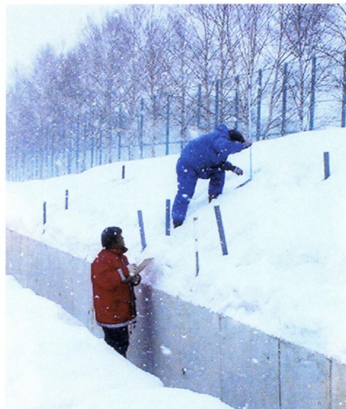
北見工大構内のL型擁壁凍上試験
