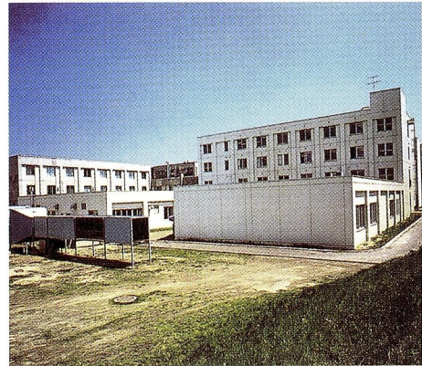
機械システム工学科棟
