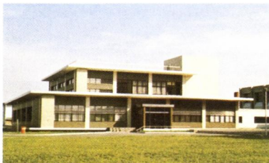
附属図書館新営工事竣工
