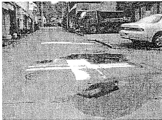
写真 6.1 パッチング補修痕の例
