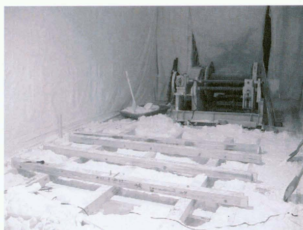
図10 新掘削場に設置したウインチ基礎 (6月6日)
