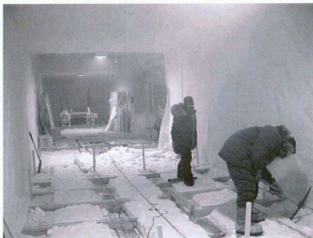
図8 新掘削場床の基礎の造成 (7月1日)
