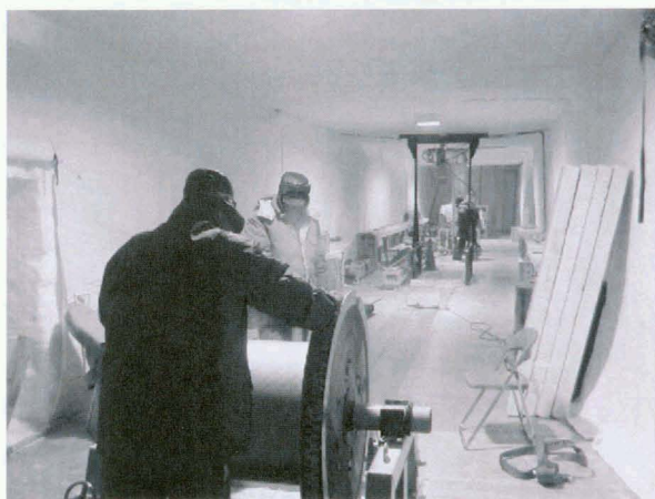
図22 ケーブル巻き取り作業(11月18日)
