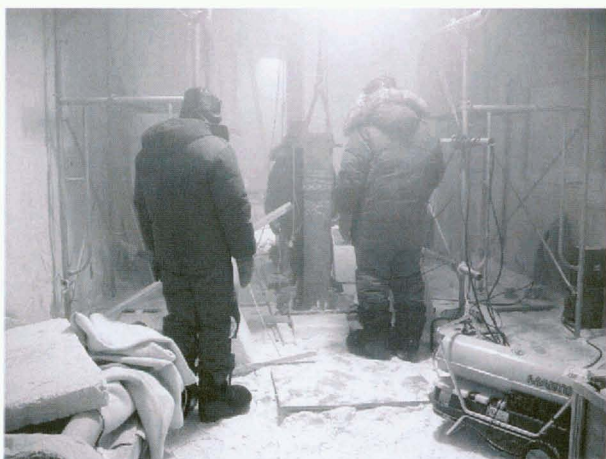
図 6 ケーシングパイプ挿入作業 (5 月 1 日)
