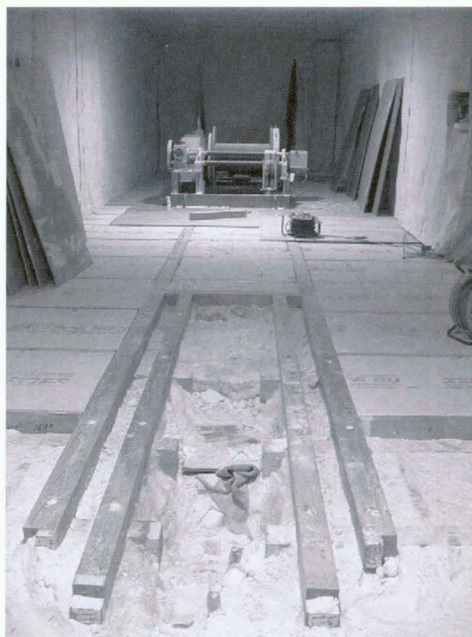
図 11 ウインチとマストとをつなぐ基礎材の構造 (6月20日)
