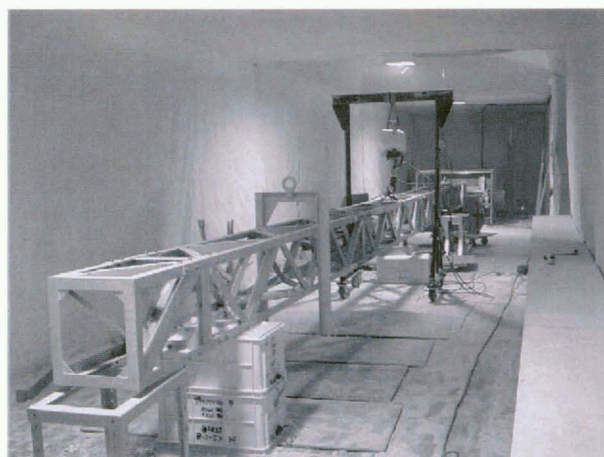
図 17 マストおよび小型門型クレーン (10月1日) Fig. 17. A mast and a small goliath crane (October 1, 2003).
