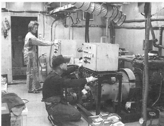
写真3 ディーゼル発電機の点検の様子(2003年3月撮影)。
