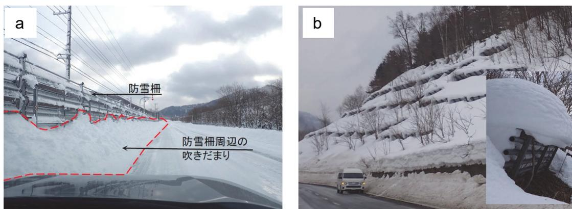
図 1.3 防雪対策工の現状の事例。(a) 防雪柵周辺の吹きだまりの事例、(b) 雪崩予防柵周辺の雪庇発達の事例。
