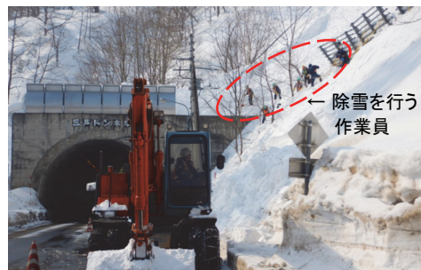
図-2 雪崩予防として法面除雪を行う作業員
