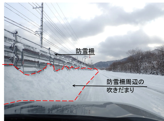
図-1 防雪柵周辺の吹きだまり状況の事例
