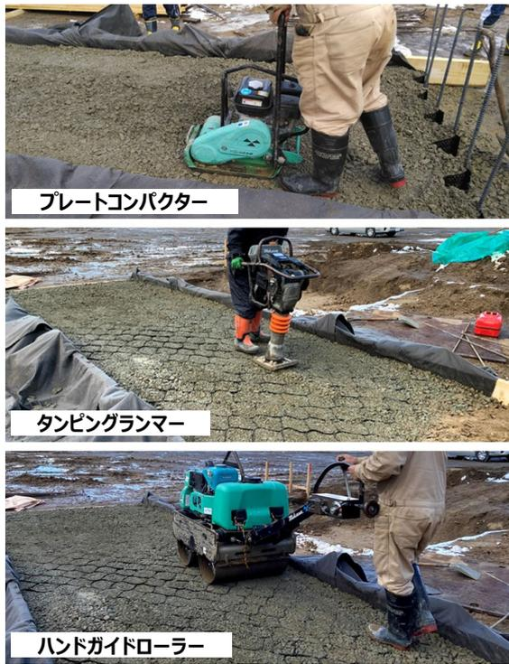
写真-4 締めめ機械を用いた転圧の様子
