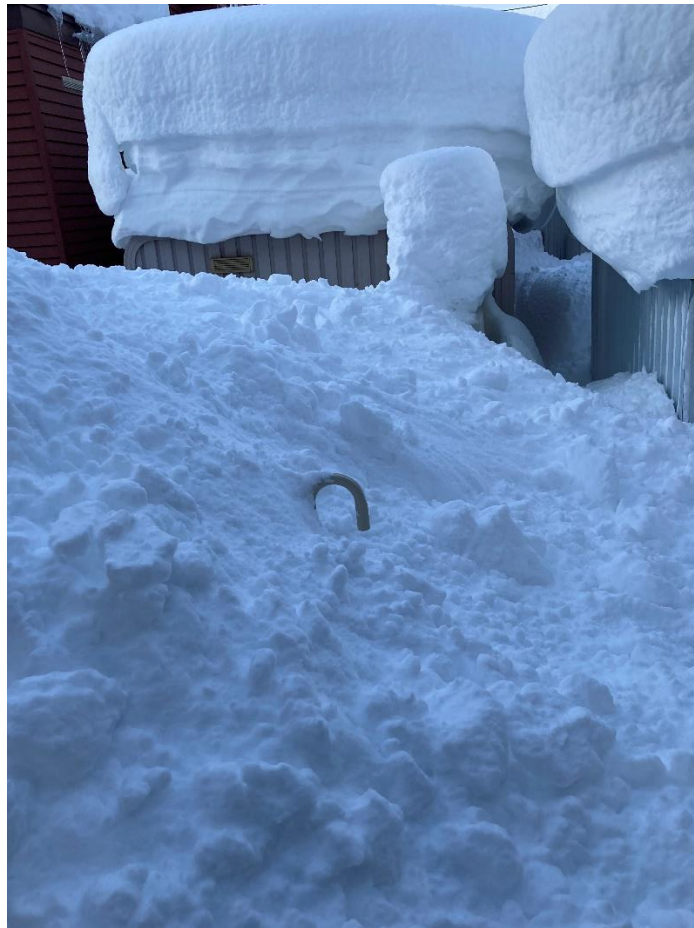
写真3-11 490型灯油タンクがほぼ埋まった状況（中央に空気抜き曲管が少し見える）
