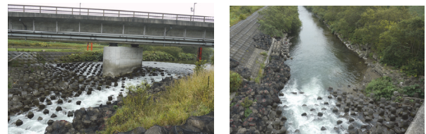
写真-2 下鑑別橋の護床工（2013年撮影）
