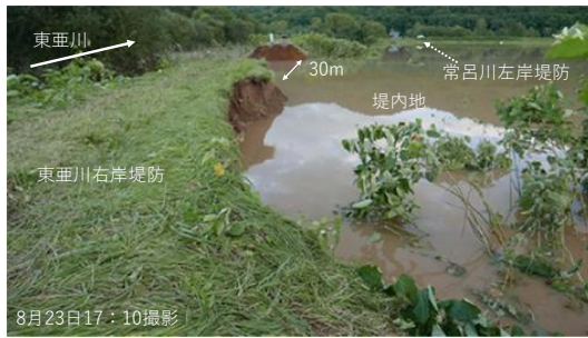
図-9 東亜川における破堤の状況
