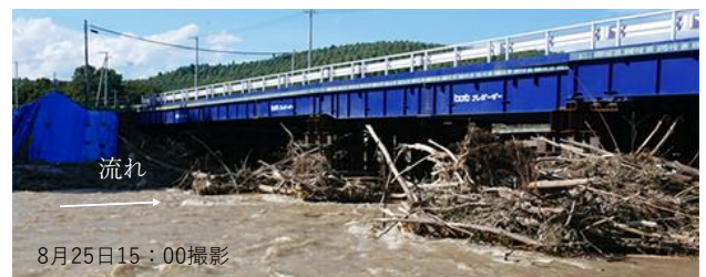
図- 19 清見橋 (仮設) の橋脚に集積している流木
