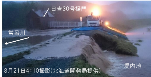
図-10 常呂川KP22.6左岸における堤防裏法の浸食
