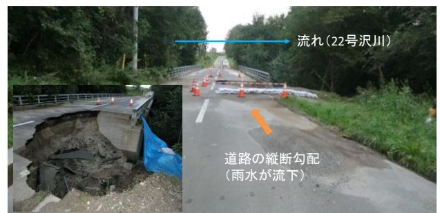
図- 20 22号沢川における橋台背面の浸食
