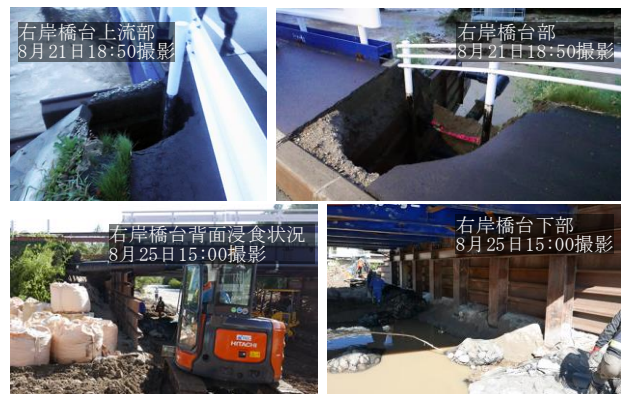
図- 18 清見橋 (仮設) の被災状況
