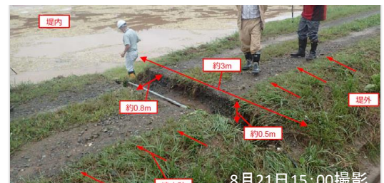
図-14 KP24.0右岸堤防の天端の浸食状況
