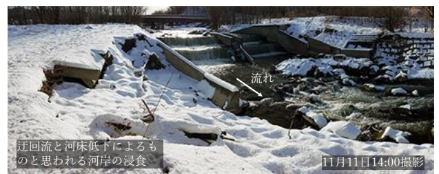
図- 22 無加川第5落差工の被災状況
