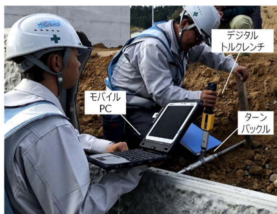
写真-5 施工中行ったトルク計測の様子
