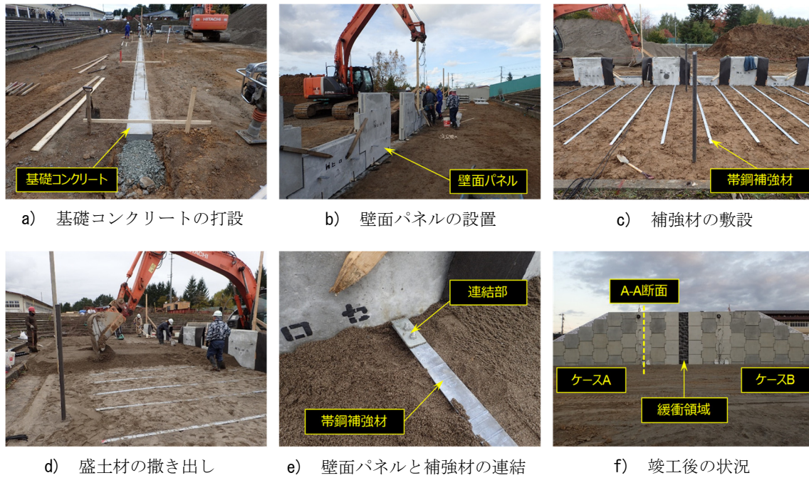
写真 2-8 試験補強土壁の施工状況
