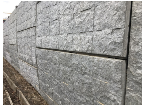
b) 壁面パネルの変状状態の例
