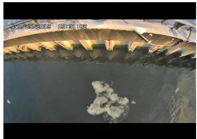
図-2 網走川特殊堤コンクリート矢板と流下河氷 (河氷長辺約2m四方)
