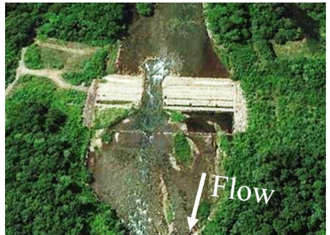
図-4 戸蔭別川第5号床固工
