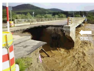
図-1 空知川太平橋での被災事例(文献 3) に修正・加筆)
