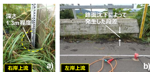
図-7 側壁・翼壁付近の状況
