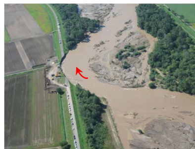
写真-1 音更川での2011年出水での堤防流出状況
