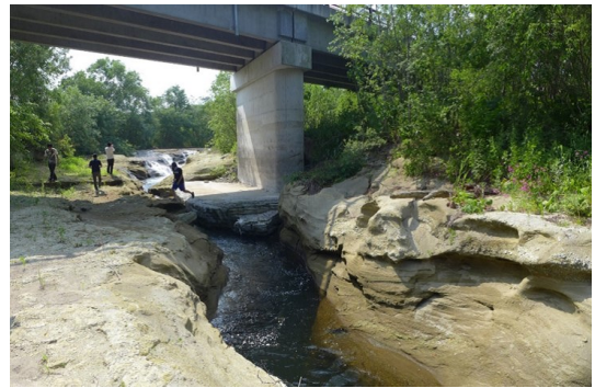
図-1 軟岩の浸食により橋脚の基礎が露出した例
