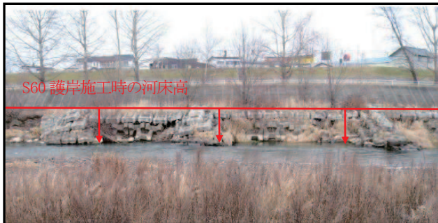
写真-1 KP6.2付近の護岸被災状況
