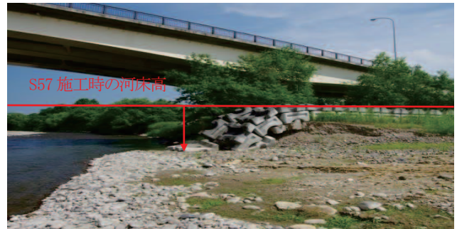
写真-2 KP5.5付近の橋脚被災状況
