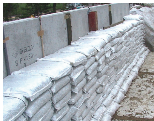
写真-3 土のうの設置状況
