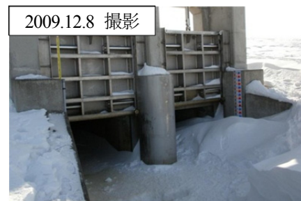
図-3 ゲート部の結氷及び積雪状況
