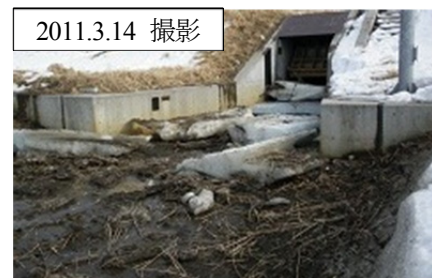
図-2 樋門ゲート前面の氷板痕跡
